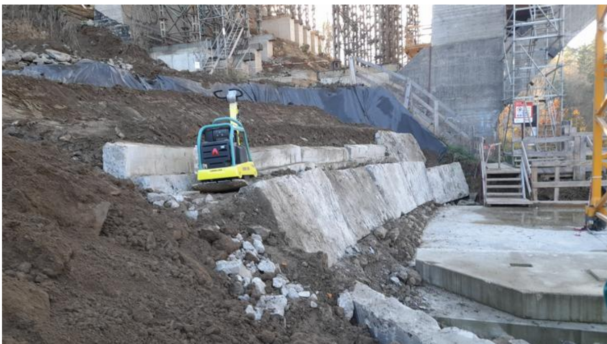
Obr. 2 Plošina č. 1 – pohled zdola Fig. 2 Platform no. 1 – bottom view
