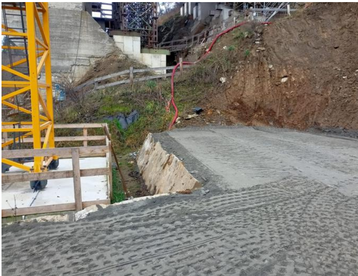
Obr. 3 Plošina č. 2 – v době budování Fig. 3 Platform no. 2 – during construction works
